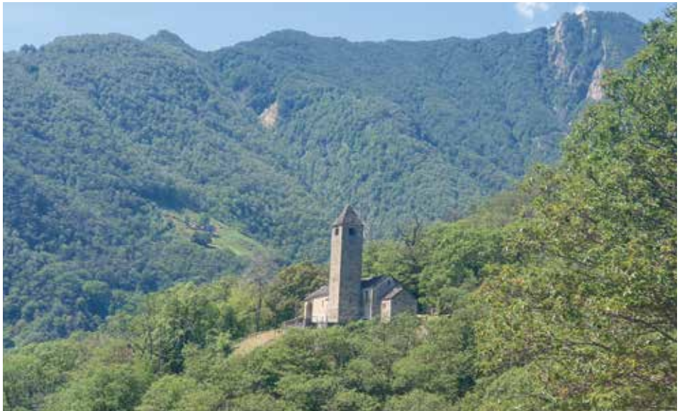
Bild: Kirche San Bernardo in Curzutt
